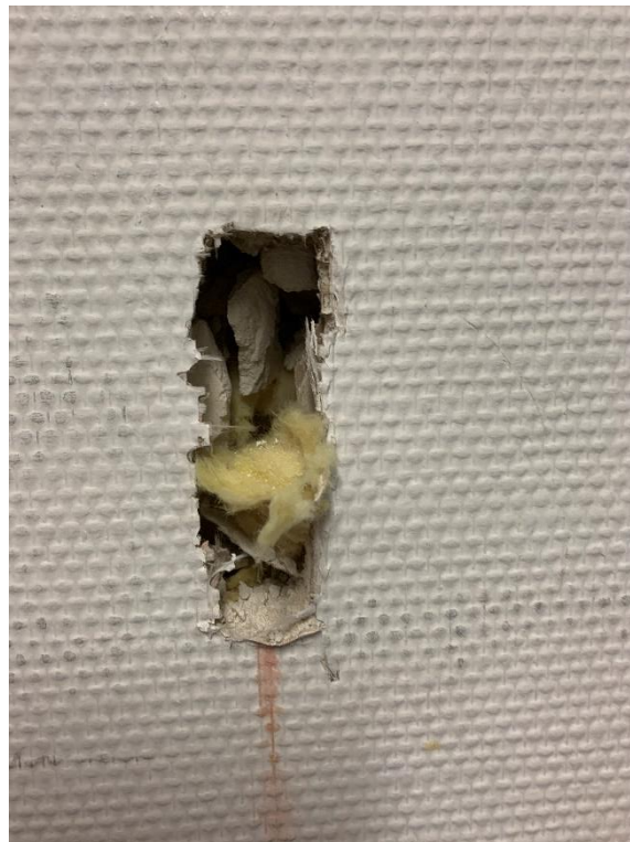
Abbildung 2: Mineralwolle in der Zwischenwand
