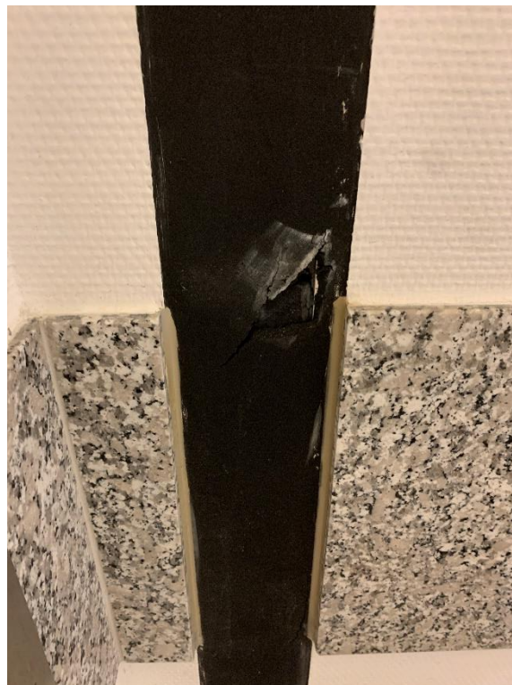
Abbildung 3: Dehnungsfuge im Gebäude
