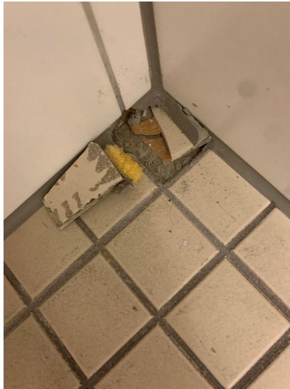
Abbildung 5: Fußboden mit Kleber und Dämmung
